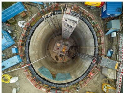
Herstellung einer Schachtbaugrube von oben gesehen
